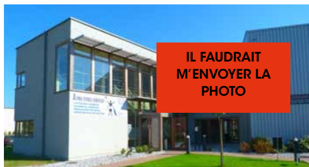
Perwez, bâtiment basse énergie
