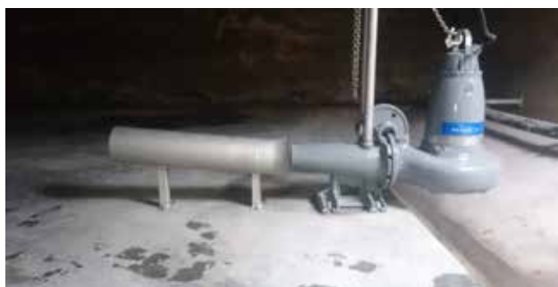
Travaux de rénovation du bassin de stockage des boues tertiaires (montant des travaux: 65.000 € HTVA) (station d'épuration de la Vallée de la Lasne)
