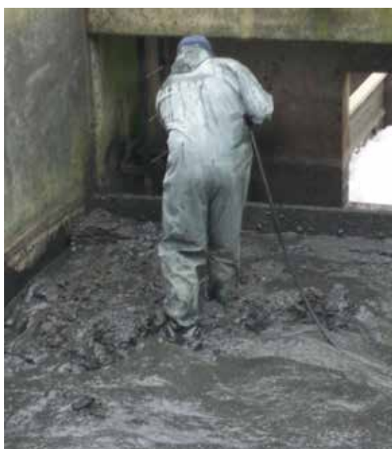
Vidange d'un bassin biologique pour arrêt
