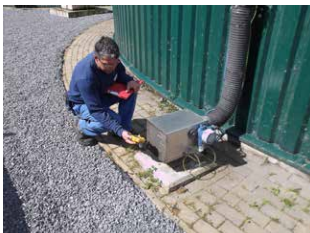
Ronde de sécurité à la station d'épuration de la Vallée de la Dyle
