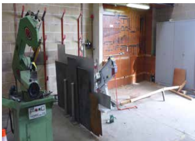
Rénovation complète de l'atelier de la station d'épuration de la Vallée de la Dyle
