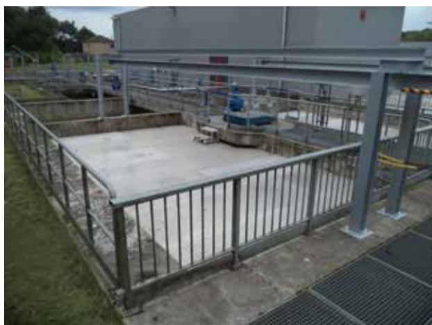
Densadeg: avant travaux / après
