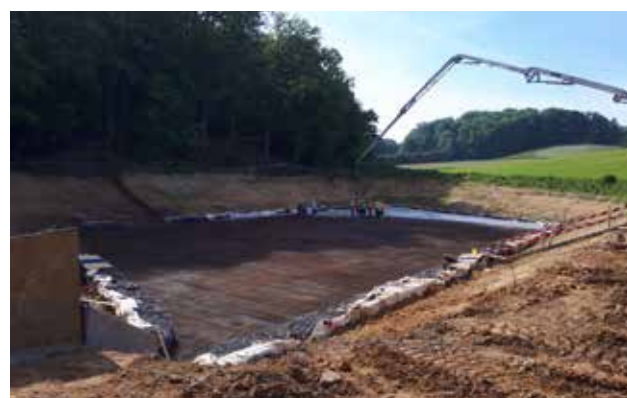
Wavre - Bois du Manil BO amont ferrailage (2)
