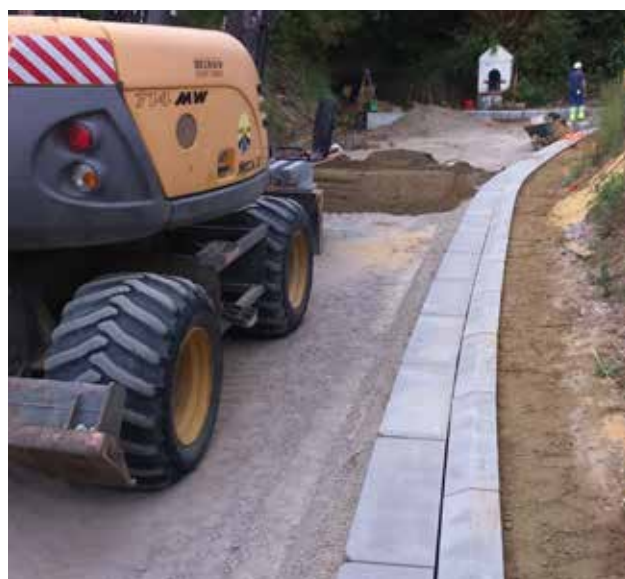
Pose d'éléments linéaires rue du Pré Delcourt à Chaumont-Gistoux.
