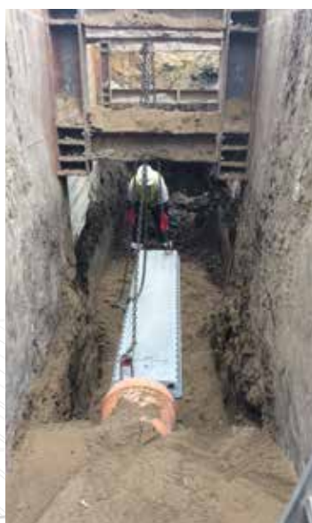
Perwez - Longpré pose égout sur pieux et dalle
