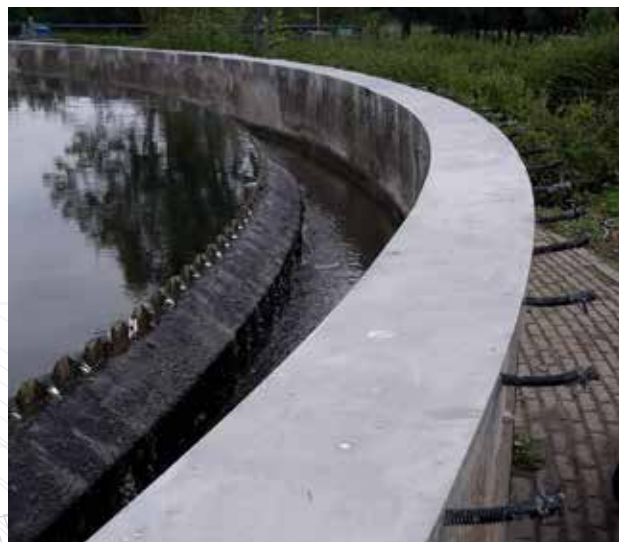
Rénovation des chemins de roulement
