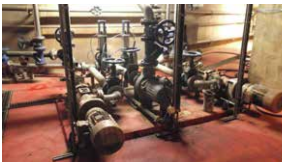
Pompes à vis excentrée
