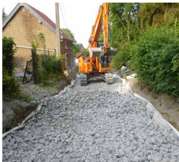
Ramillies-rue du mariva pose de la sous-fondation (1)
