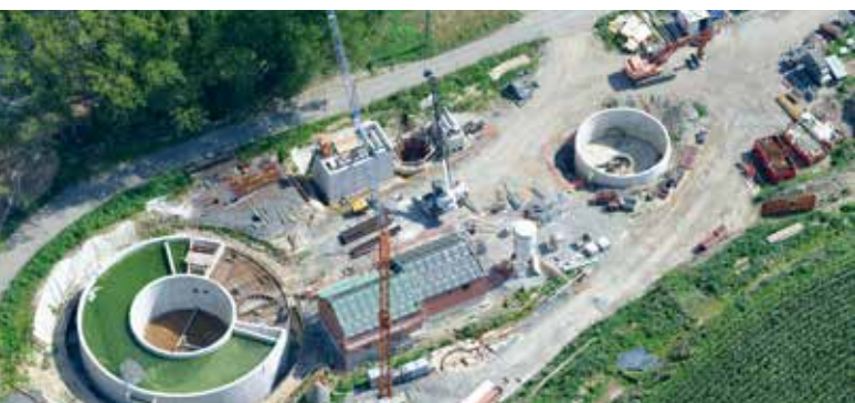
chantier construction Step Oisquerca
