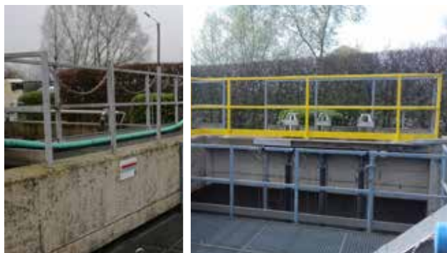
avant rénovation à gauche, après rénovation à droite
