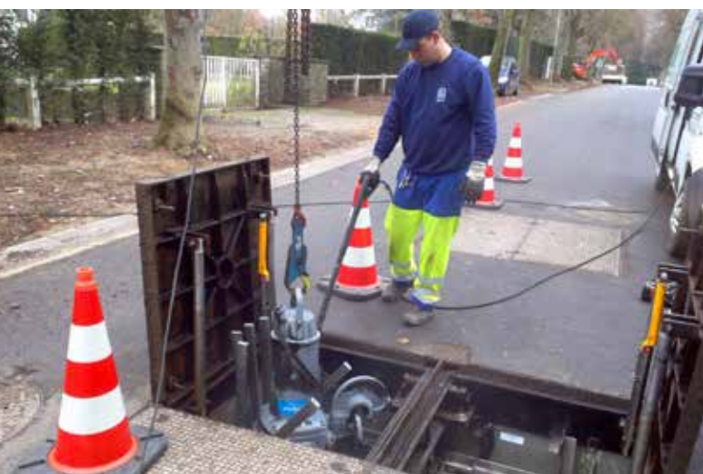
Extraction d'une pompe immergée en voirie et nettoyage de la pompe avant maintenance (station de pompage Waterloo Manoir)
