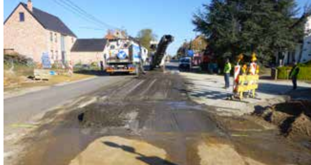
Collecteur Gette lot 3B - Pose collecteur et refaction chaussée RN91
