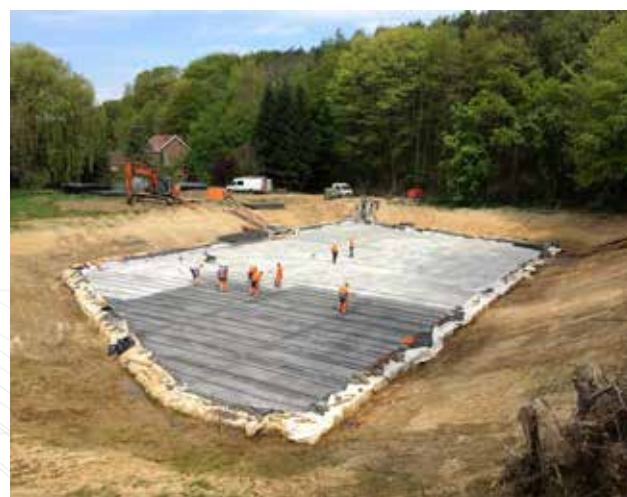
Wavre - Bois du Manil BO amont ferrailage
