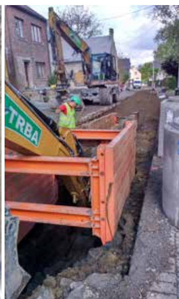
Pose d'égouttage rue de la Cruchenère à Walhain.
