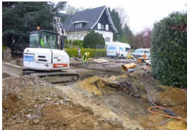
Collecteur Gette lot 3B - Pose collecteur et refaction chaussée RN91
