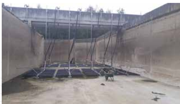
Travaux dans le bassin biologique
