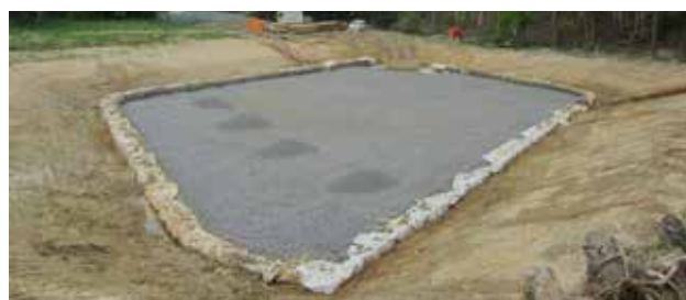
Wavre - Bois du Manil BO amont empierrement
