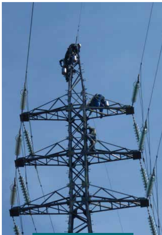
Entretien pylône haute tension.
