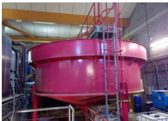
Atelier de déshydratation (flottateur)
