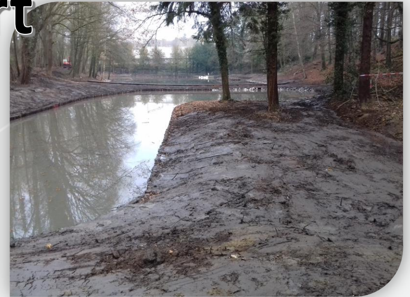
Vue d'ensemble après travaux
