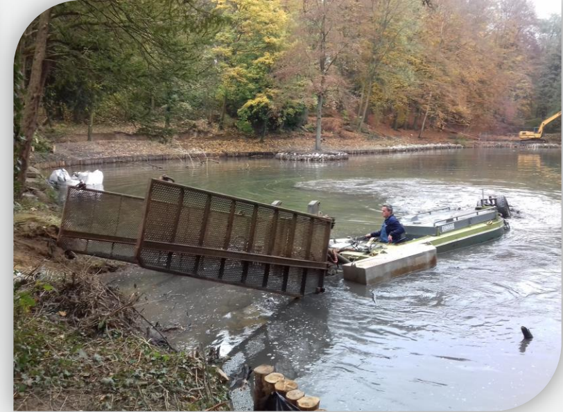
Barge de curage
