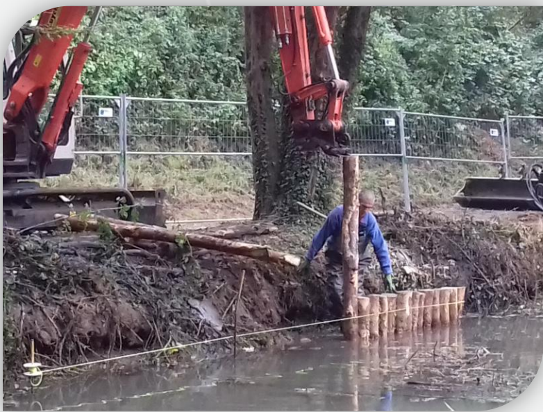
Mise en place des Pieux
