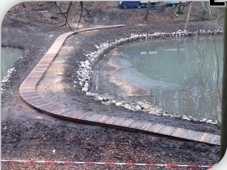
Passerelle de promenade
